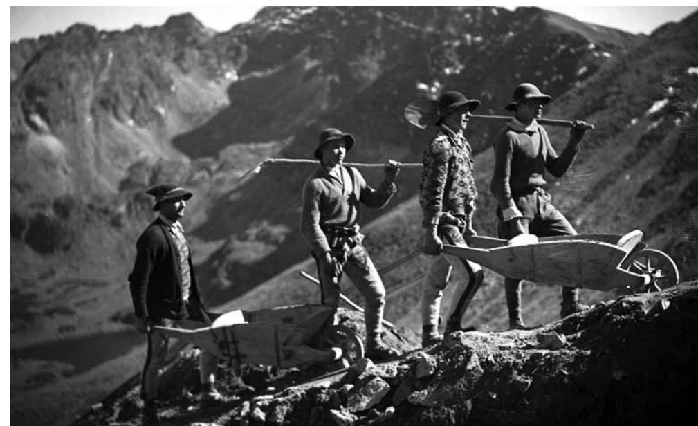
Kolej linowa na Kasprowy Wierch w Zakopanem została oddana do użytku 15 marca 1936 roku. Zbudowano ją w zaledwie 7 miesięcy, nie zważając na mrozy, śnieżne zadymki, które są chlebem powszednim w Tatrach. Gdy ją rozpoczynano 1 sierpnia 1935 roku, na budowie było wówczas 100 osób, w październiku uwijało się już 600 ludzi, a w ostatnich tygodniach, tuż przed oddaniem inwestycji, pracowało ponad 1000 robotników. Fachowców ściągano już spoza Zakopanego, bo w stolicy Tatr zabrakło rąk do pracy.
